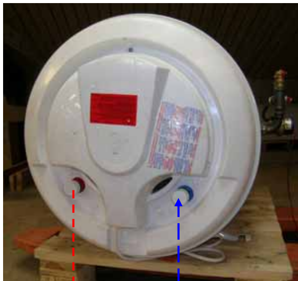
TWW-Speicher Unterseite Vorerwärmtes Wasser Austritt Kaltwassereintritt
